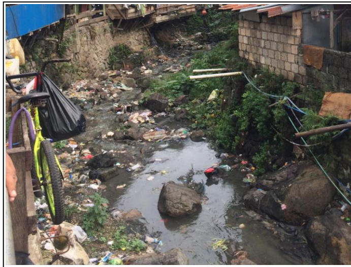
Gambar 9. Contoh Kondisi Saluran Pasangan Batu yang Rusak Sumber: Profil Kawasan Permukiman Kumuh, 2017
