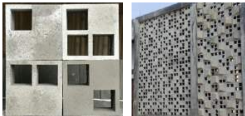
Gambar 1.48 Roster Tipe Dadu dengan Berbagai Jenis Lubang yang Dikombinasikan dan Digunakan pada Fasad Bangunan
