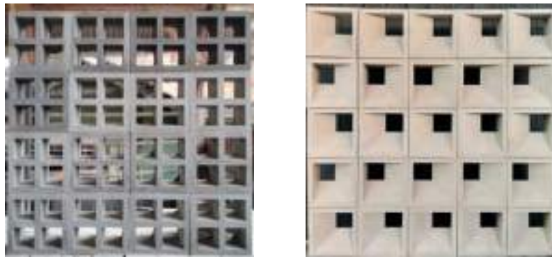
Gambar 1.47 Roster Tipe Kotak dan Tipe Kotak Sudut Memiliki Tingkat Privasi yang Berbeda
